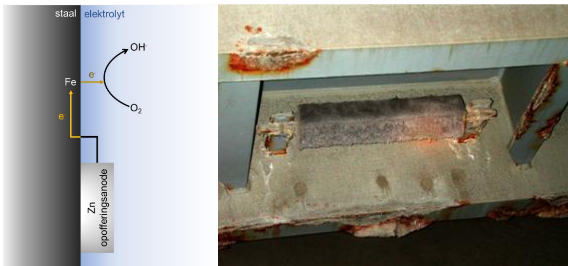
Figuur 6-19. Principe en voorbeeld van een opofferingsanode.
